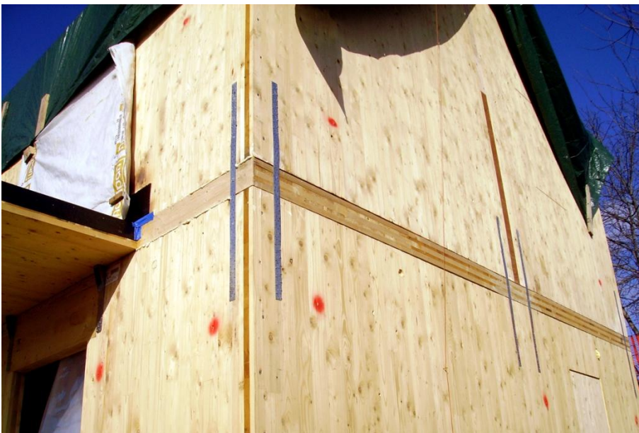
Esempi di ancoraggi tipo per struttura X-lam
