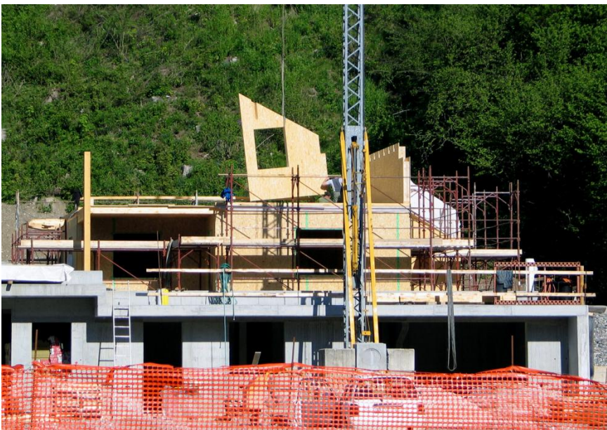
Sistemi intelaiati e controventati con pannelli
