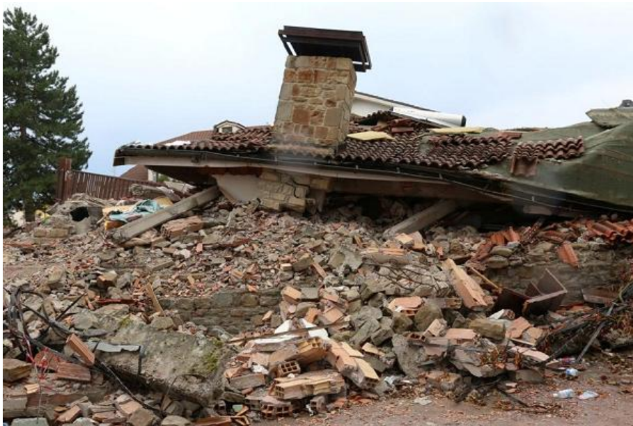
Collassi totale con schiacciamento dall'alto
